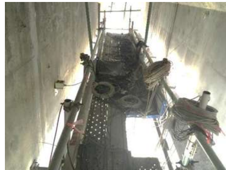
(ข) การเชื่อมต่อสายสัญญาณ
