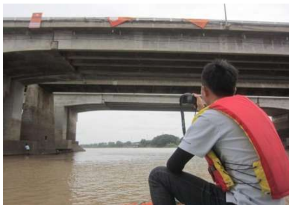
รูปที่ 2.2-1 การดำเนินงานตรวจสอบสภาพสะพานเดชาติวงศ์ 2
