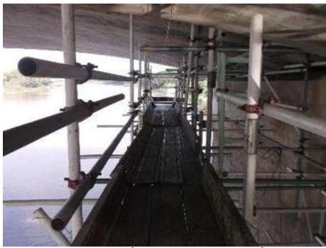
(ก) นั่งร้านบริเวณคานยื่น
