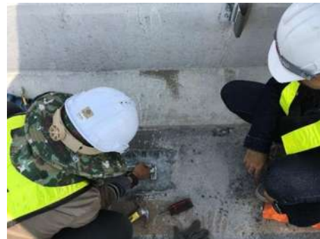
(ง) การติดตั้ง Strain Gauge บริเวณพื้นสะพาน
