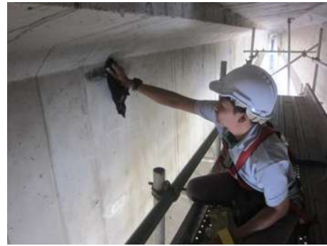
(ข) การทำความสะอาดผิวงานด้วยอะซิโตน
