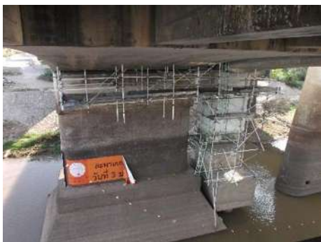
(ค) นั่งร้านบริเวณตอม่อ
