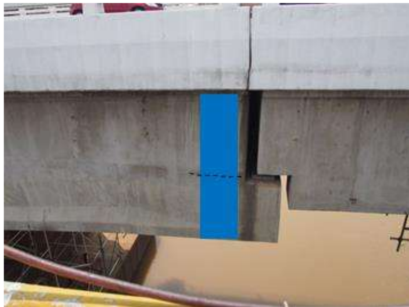
รูปที่ 8.2-25 การเสริมกำลังรับแรงเฉือนโดยใช้วัสดุคอมโพสิตเสริมเส้นใยสำหรับคานช่วงยื่น 11 เมตร
