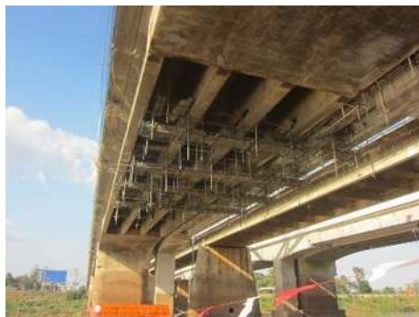
(ก) นั่งร้านบริเวณคานแขวน
