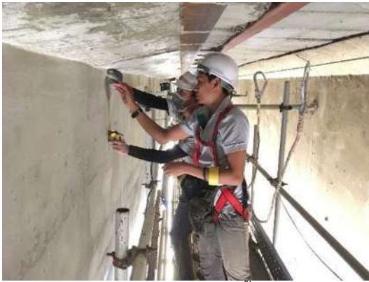
(ก) การกำหนดตำแหน่งติดตั้ง Strain Gauge
