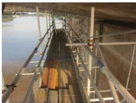
(ค) นั่งร้านบริเวณคานยื่น
