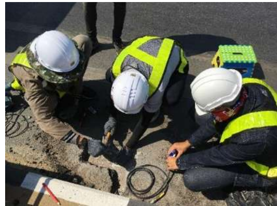
(ง) การติดตั้ง Strain Gauge ได้ผิวแอสฟัลต์
