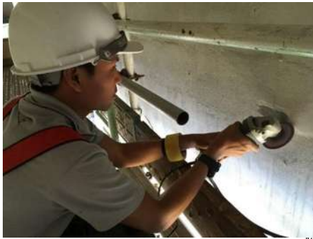
(ก) การปรับผิวงานให้เรียบก่อนการติดตั้ง
