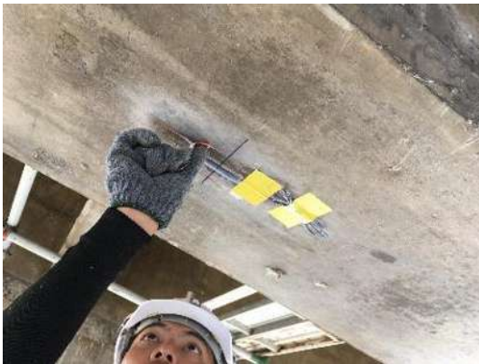
(ค) การติดตั้ง Strain Gauge ที่ชิ้นส่วนโครงสร้าง
