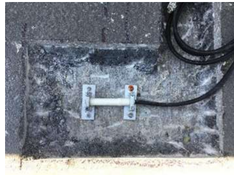
(ข) Strain Gauge ที่พื้นสะพานใต้ผิวแอสฟัลต์
