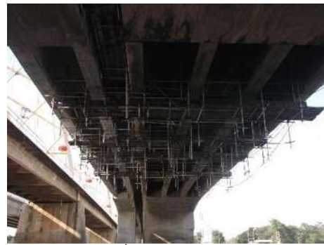
(ข) นั่งร้านบริเวณคานแขวน
