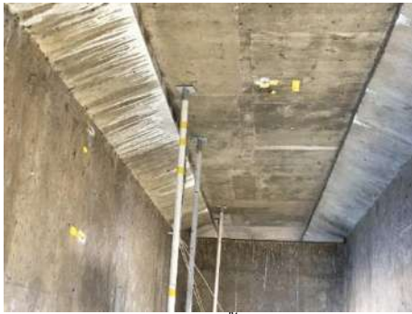
(ก) หลังการติดตั้ง Strain Gauge
