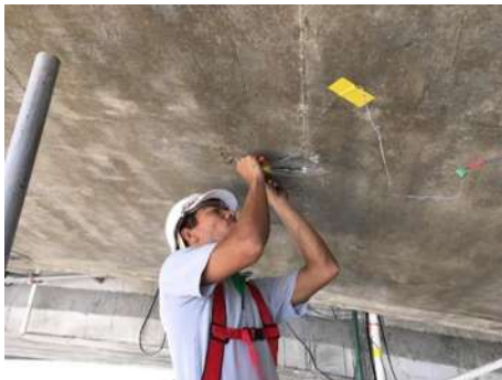
(ค) การติดตั้ง Strain Gauge บริเวณคานสะพาน
