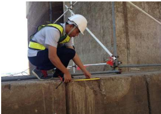
รูปที่ 2.3-1 การดำเนินงานตรวจสอบสภาพสะพานเดชาติวงศ์ 3
